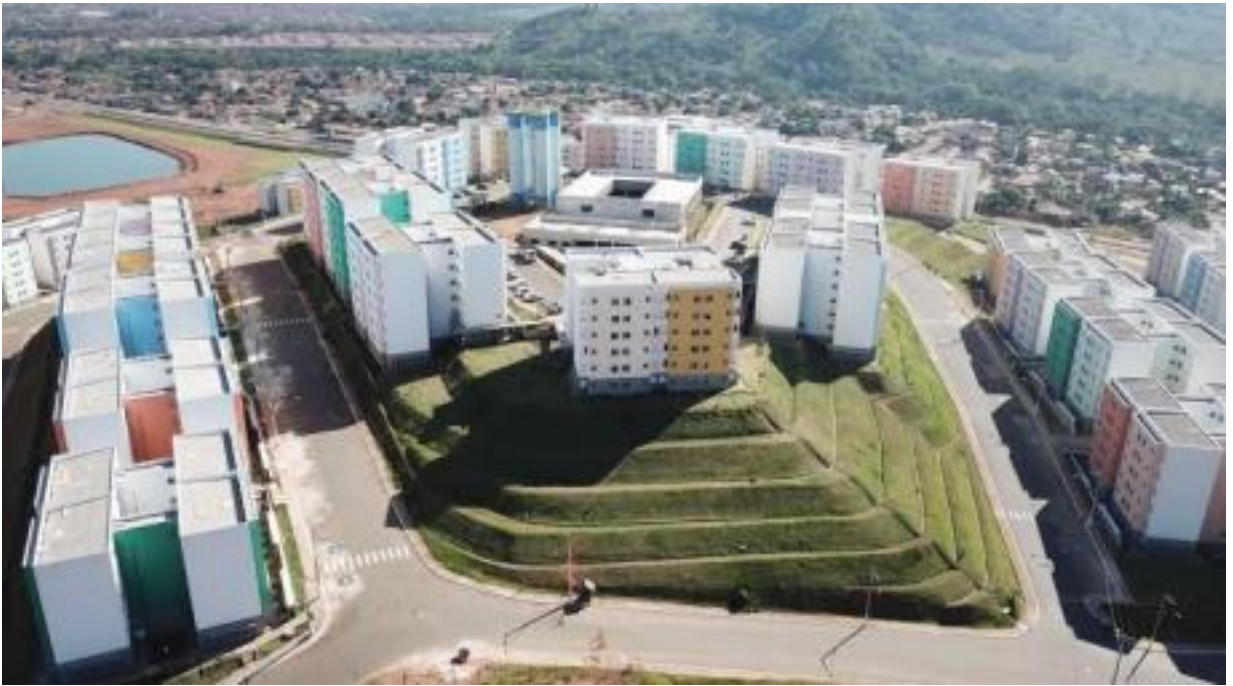
Figura 4 – Prédios do projeto habitacional social do residencial alto bonito
